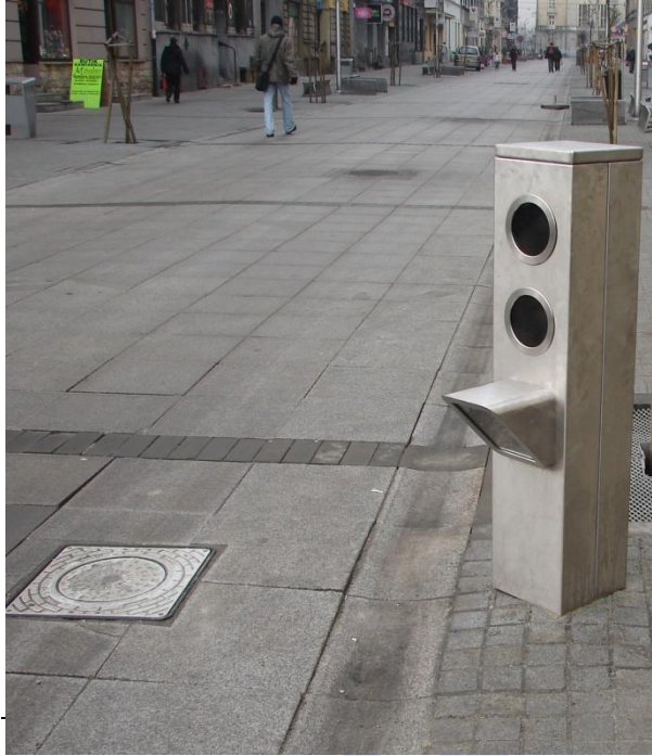
Rysunek 1. Słupek z wbudowaną kamerą do automatycznego rozpoznawania tablic rejestracyjnych wraz z sygnalizacją czerwone-zielone światło (po lewej opuszczony słupek hydrauliczny)
