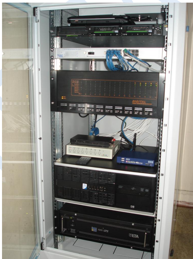
Rysunek 9. Zespół urządzeń nadzorujących pracę systemu strefy ograniczonego ruchu.
